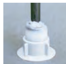
ブチルに丸セパレーターを挿入
