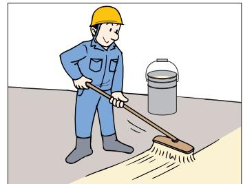
NS高性能プライマーSL用が乾燥していることを確認後、セルフレベリング材を所定厚打設してください。
