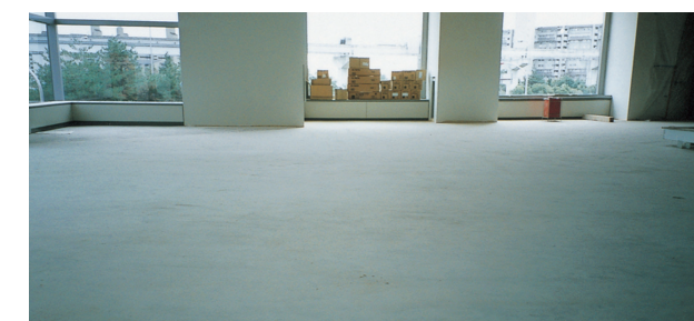
ピロティ空間の断熱工事（床冷え対策）
