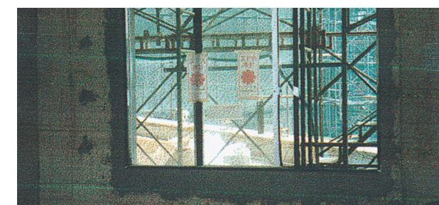
サッシ周りの断熱・結露防止工事
