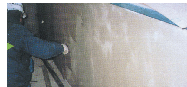
有機系断熱下地板に対する施工 （有機系下地と無機系仕上のコンビネーション）
