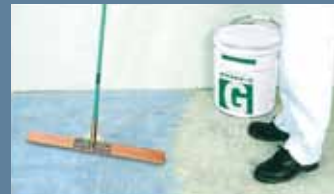
プライマー処理
