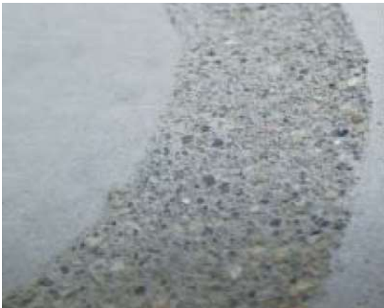
コンクリート素地（試験体）
